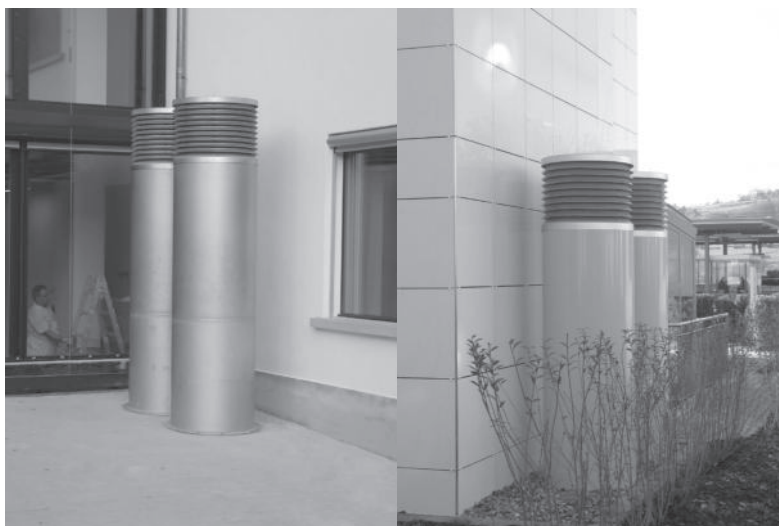
Säulen-Lamellenhut mls Standrohr längsgeschweisst mit Befestigungsflansch Aussen-/Fortluft
